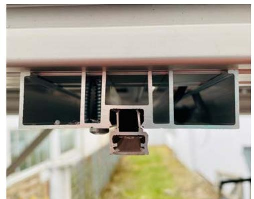
Querschnitt: montierter Kabelkanal mit LED
